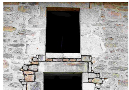
décharge par superposition d'une baie © Astrid Hyvernât
