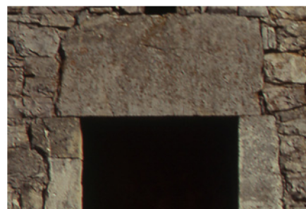
linteau à forte inertie © Manuelle Roche ADAGP
